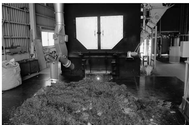
林業の振興と一体に木質エネルギーを活用。 木材加工で出た木屑を乾燥に利用（木材センター・宍粟市）
