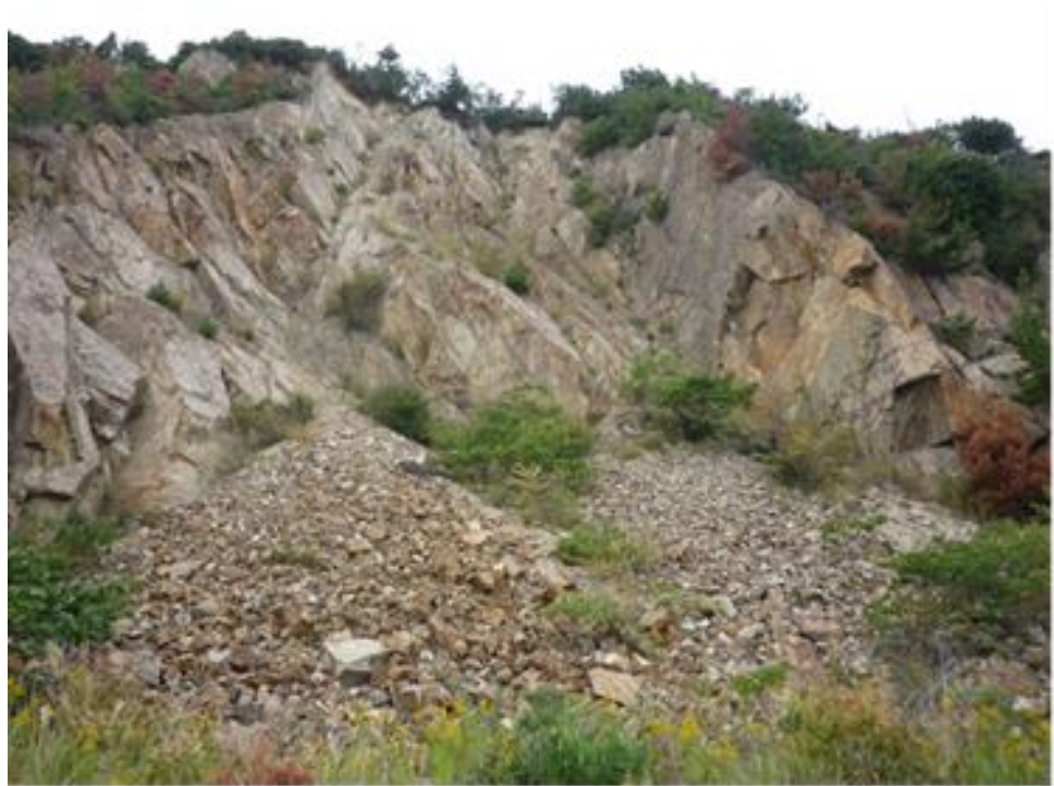
Ph4.2 碎石場への道路切り露頭に見られる楔崩壊箇所
