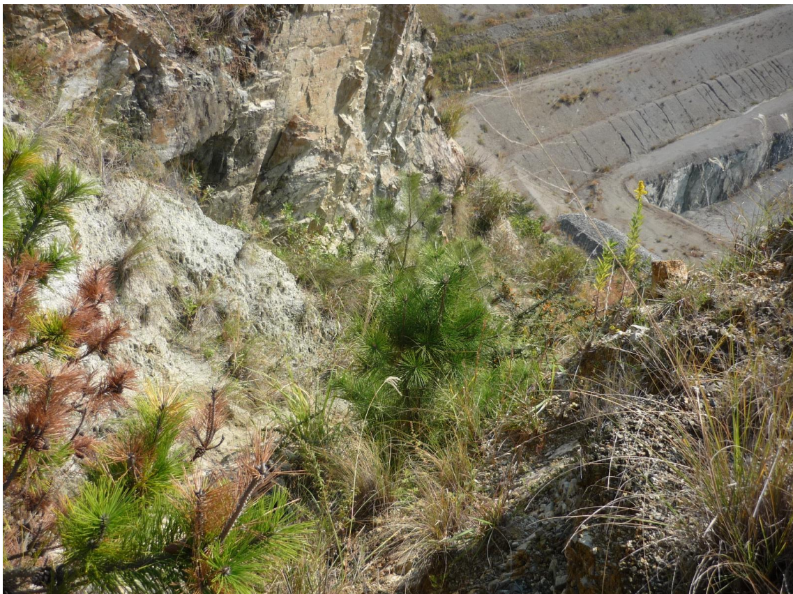
Ph3.1 北側斜面に見られる断層破碎帯
