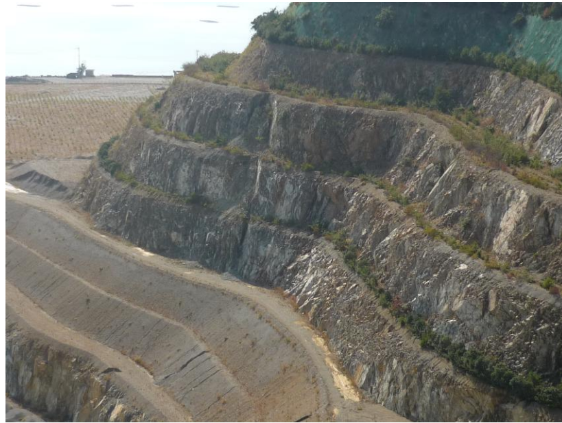
Ph3.4 南西側斜面に見られる断層
