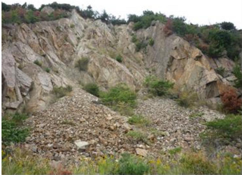
Ph4.2 碎石場への道路切割り露頭に見られる楔崩壊箇所
